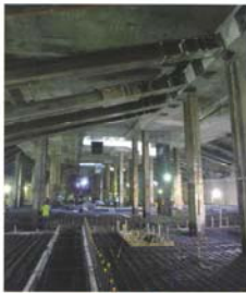
Casting Concrete for Roofslab at Opera House Station Đổ bê tông sàn mái ga Nhà Hát
