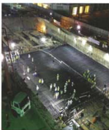
Casting Concrete for Roofslab at Opera House Station Đổ bê tông sàn mái ga Nhà Hát
